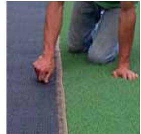
Legen Sie die Bahnen jetzt so nah wie möglich aneinander, sodass eine schöne straffe Naht entsteht. Die Bahnen dürfen sich nirgendwo überlappen. Wenn straff und gerade an der Faserreihe entlang geschnitten wird, darf zwischen den beiden Bahnen maximal 3 mm Spielraum sein. Beurteilen Sie die Naht nach der Sichtbarkeit unterschiedlicher Ränder, bevor Sie die Bahnen miteinander verbinden.
