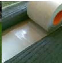
Das QuickSeam Tape ausrollen und die dünne Folie entfernen.
